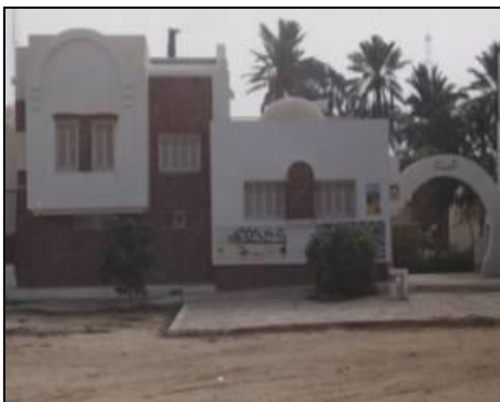
استعمال الحجر المنحوت (قابس)
