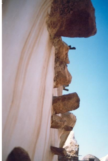
تفصيل لسقف مبني بخشب بأجذاع الزيتون وأنصاف جذع نخيل تفصيل لصقف سقيفة قصر أولاد سلطان من أجذاع شجر الزيتون و الحجارة المسطحة
