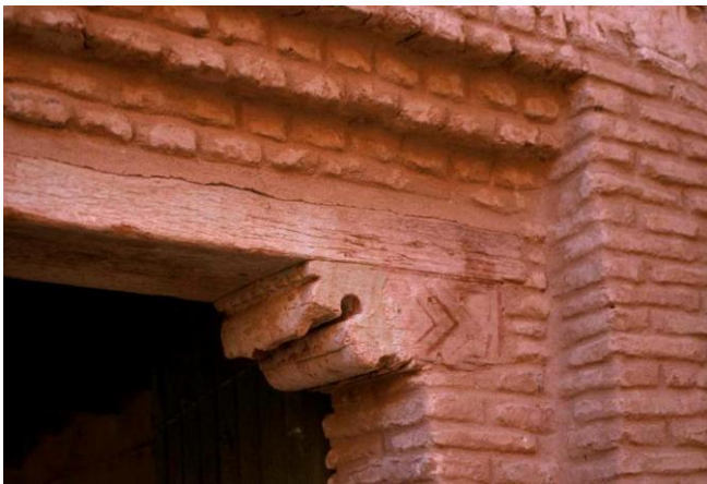
ميزاب لصرف مياه الأمطار من خشب النخيل
