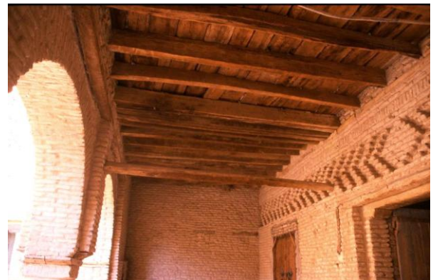
تفاصيل مختلفة لأسقف من خشب النخيل بمناطق معمار الواحات
