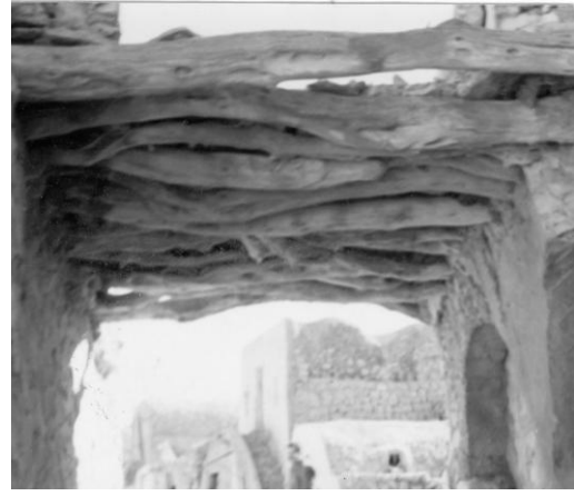
لقطة داخلية لسقف من خشب الزيتون
