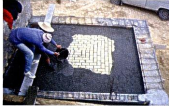
Cette voûte de briques est alors recou- verte d'un mortier de ciment.
