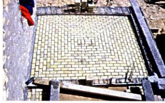
La disposition des briques se termine par la couverture totale de la forme en sable et présente une courbure qui corres- pond à la flèche désirée de la voûte.
