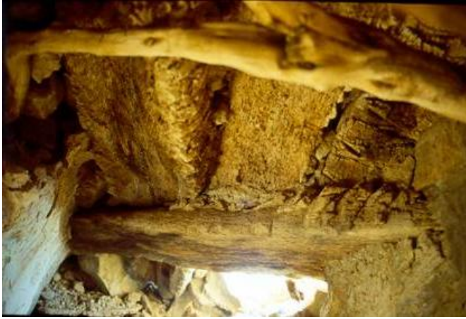
تفصيل لسقف مبني بخشب بأجذاع الزيتون وأنصاف جذع نخيل تفصيل لصقف سقيفة قصر أولاد سلطان من أجذاع شجر الزيتون و الحجارة المسطحة
