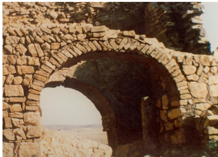
تفصيل ببناء بالحجر المفطح لقوس مدخل القصر القديم
