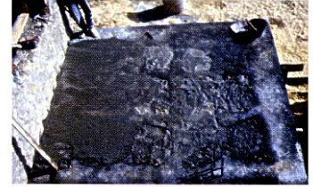
9- ثم يقع فرش طبقة أخرى من الملاط الإسمنتي الذي يصلب بمسطرة خشبية لتحديد انحدار السقف لغاية تصريف مياه
