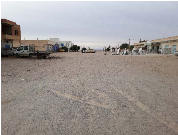
Photo 1 : Constructions au début du projet
