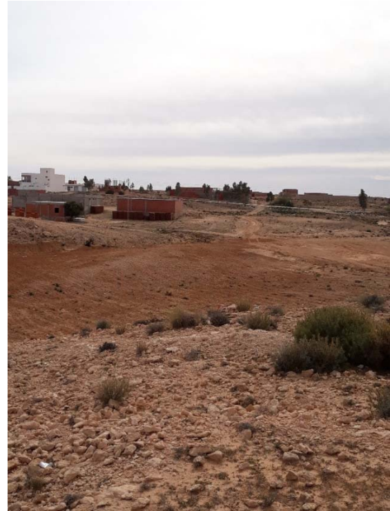
Photo 2 : Constructions au niveau de la RR113
