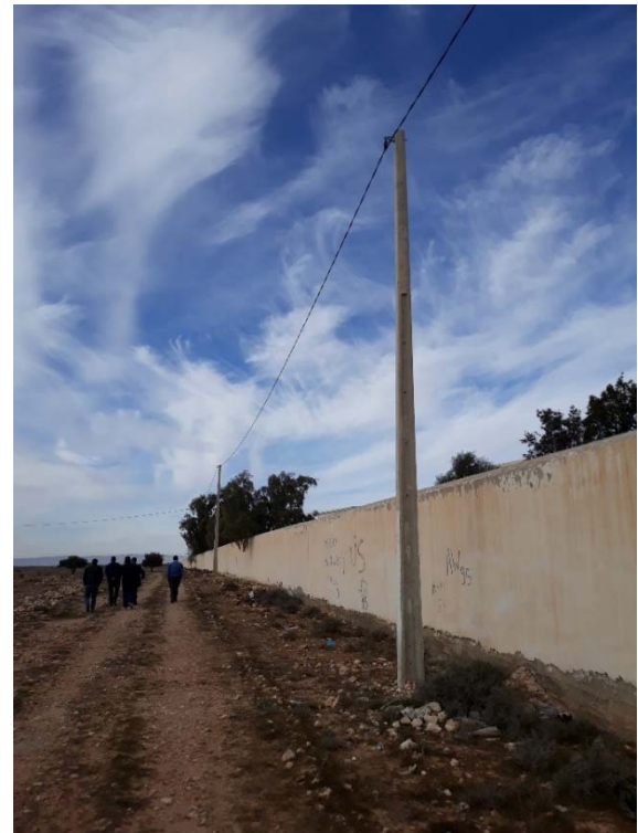
Photo 10 : Couloir de la rocade au PK6+900
