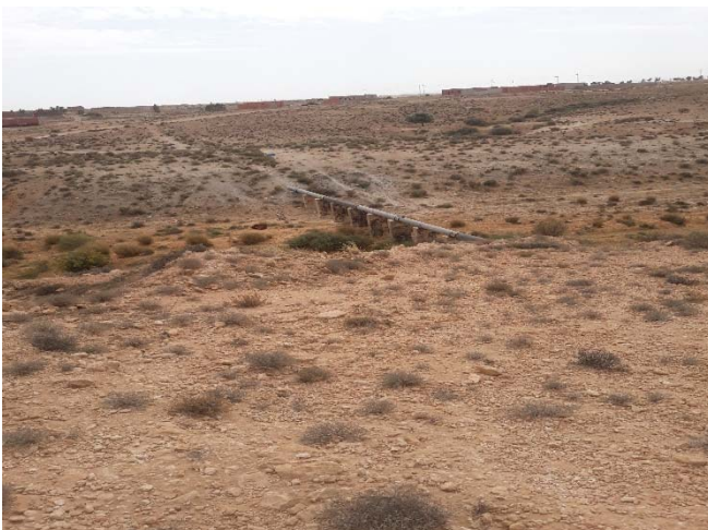
Photo 3 : conduite SONEDE Ø 400 en fonte
