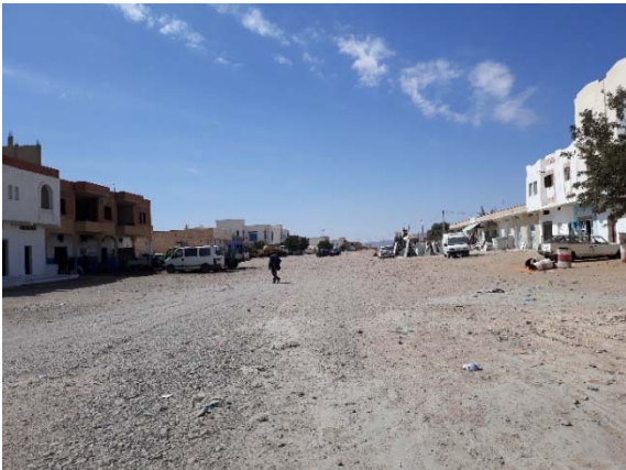
Photo 9 : Couloir de la rocade au PK0+100
