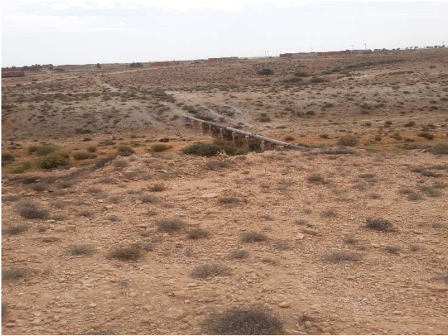
Photo 3 : conduite SONEDE Ø 400 en fonte
