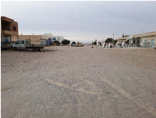
Photo 1 : Constructions au début du projet
