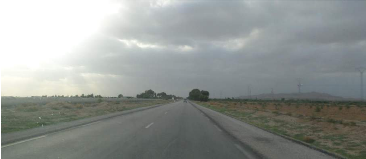
Figure 8 : Traversée du Garaât Al Akarich
