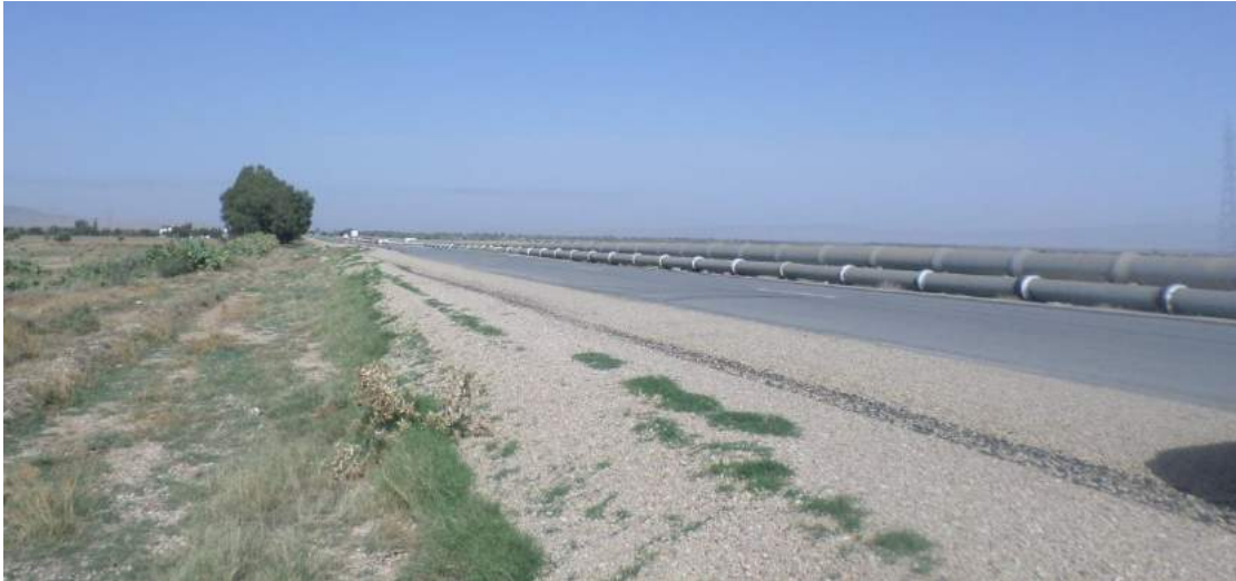
Figure 9 : Les conduites SONEDE longeant la RN13
