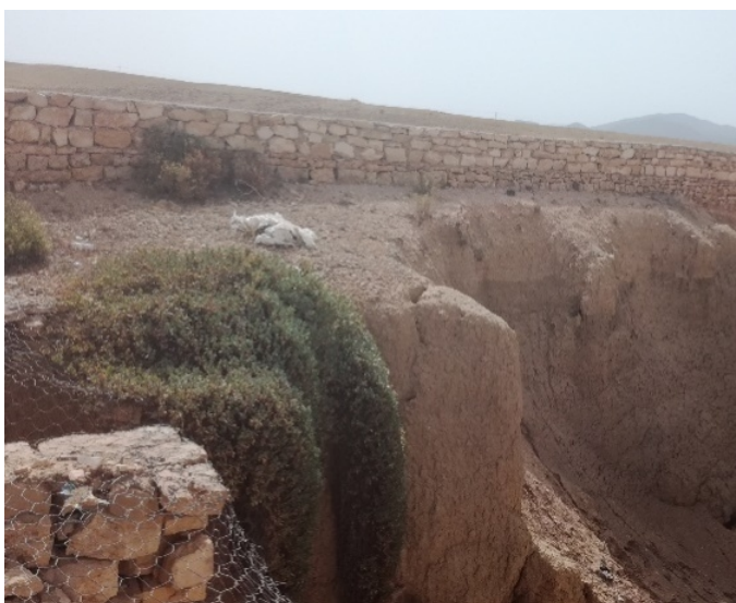
Photo 13 : Mur de protection de la route (terrain affouillable)
