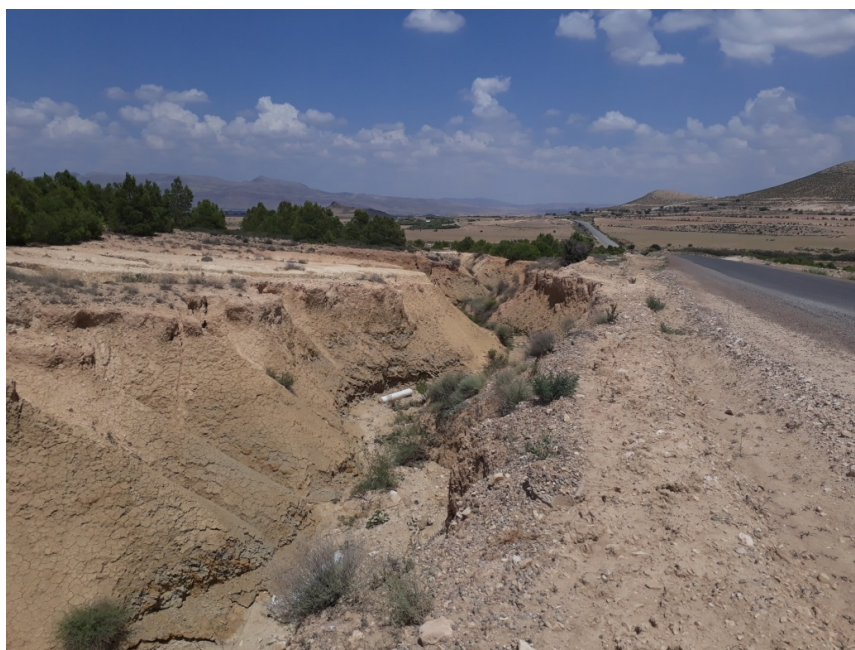
Photo 2 : Ecoulement longeant la route à droite
