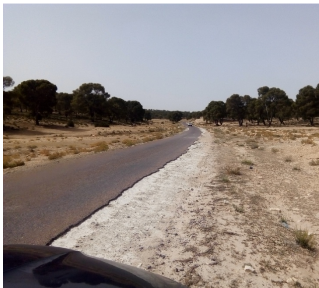
Photo 10 : Chaussée très étroite
