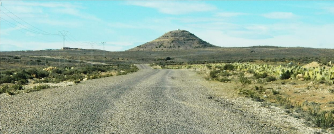
Tracé en relief vallonné à accotement variables et fossés inexistant
