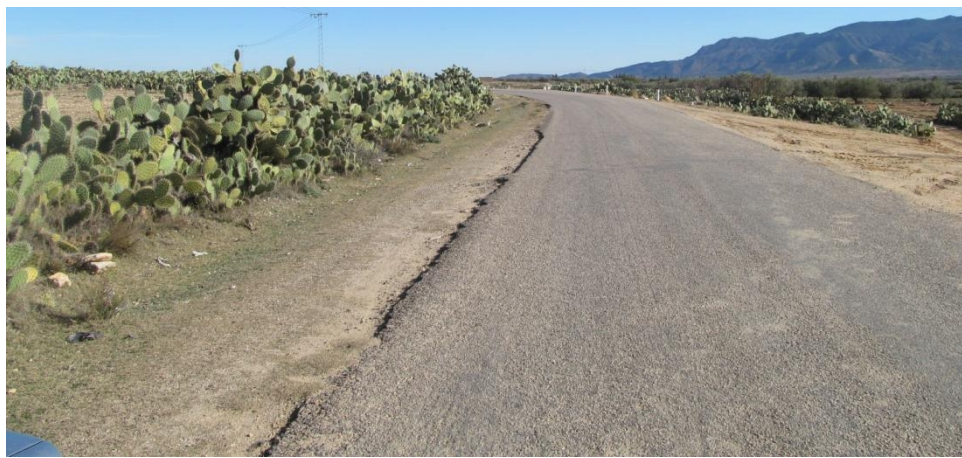
Virage serré au niveau du PK24
