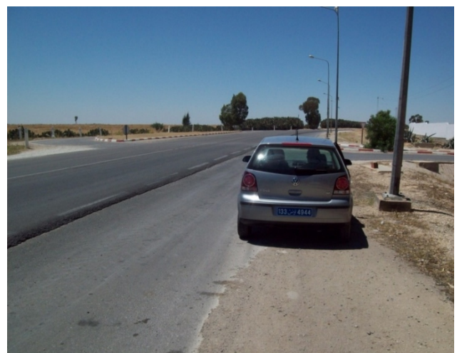
Giratoire (Zone industrielle Kondar)
