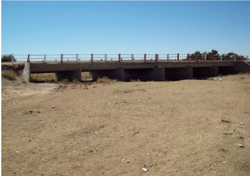
Figure 6 : Ouvrage d'Art : Pk 11.1
