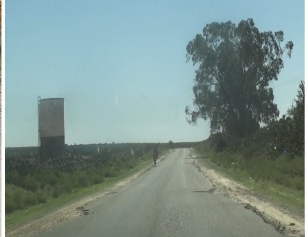
Photo n°1 : épaufures au niveau des bords de la chaussée
