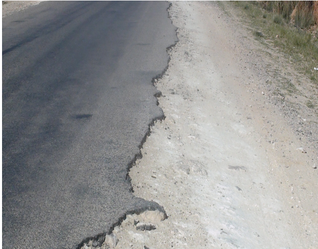
Photo n°1 : épaufures au niveau des bords de la chaussée
