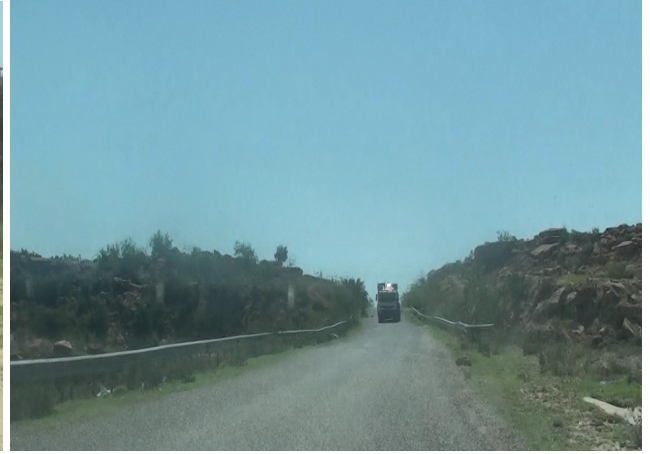
Photo n°5 : Route en déblai
