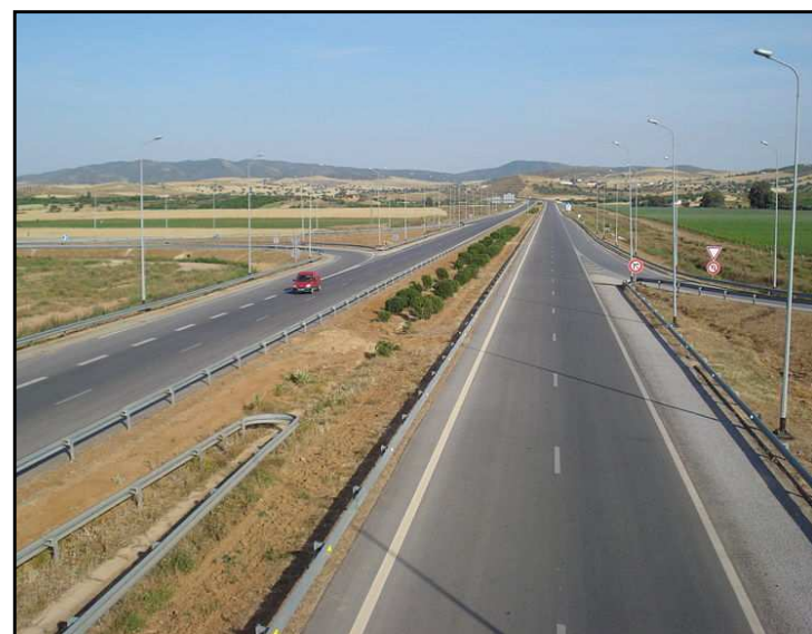
Autoroute de Béja (Oued Zarga)
